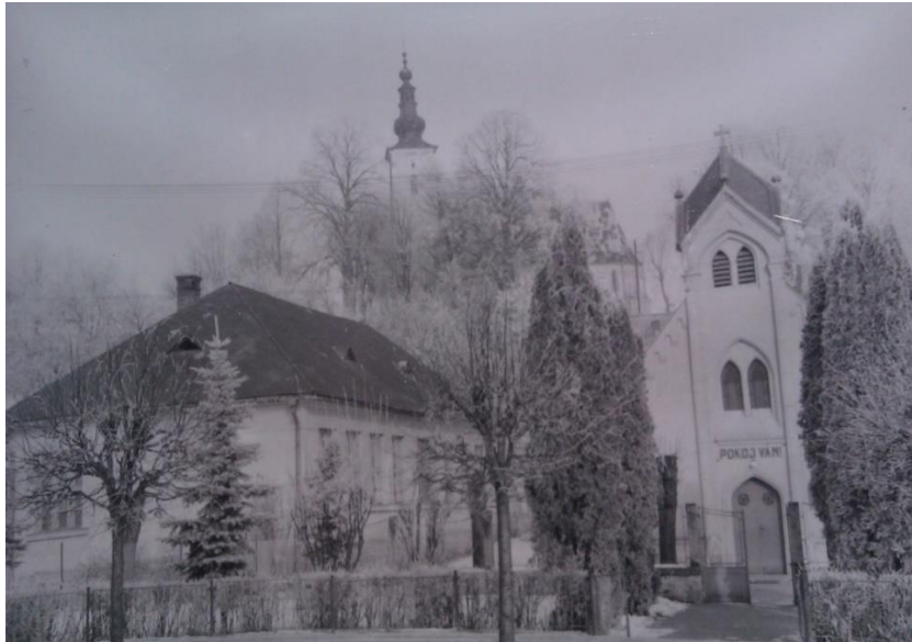
Budova r.Ľudovej školy v Gaboltove – fotografia zo 70-tych rokov 20. storočia (súkr. archív autora).
