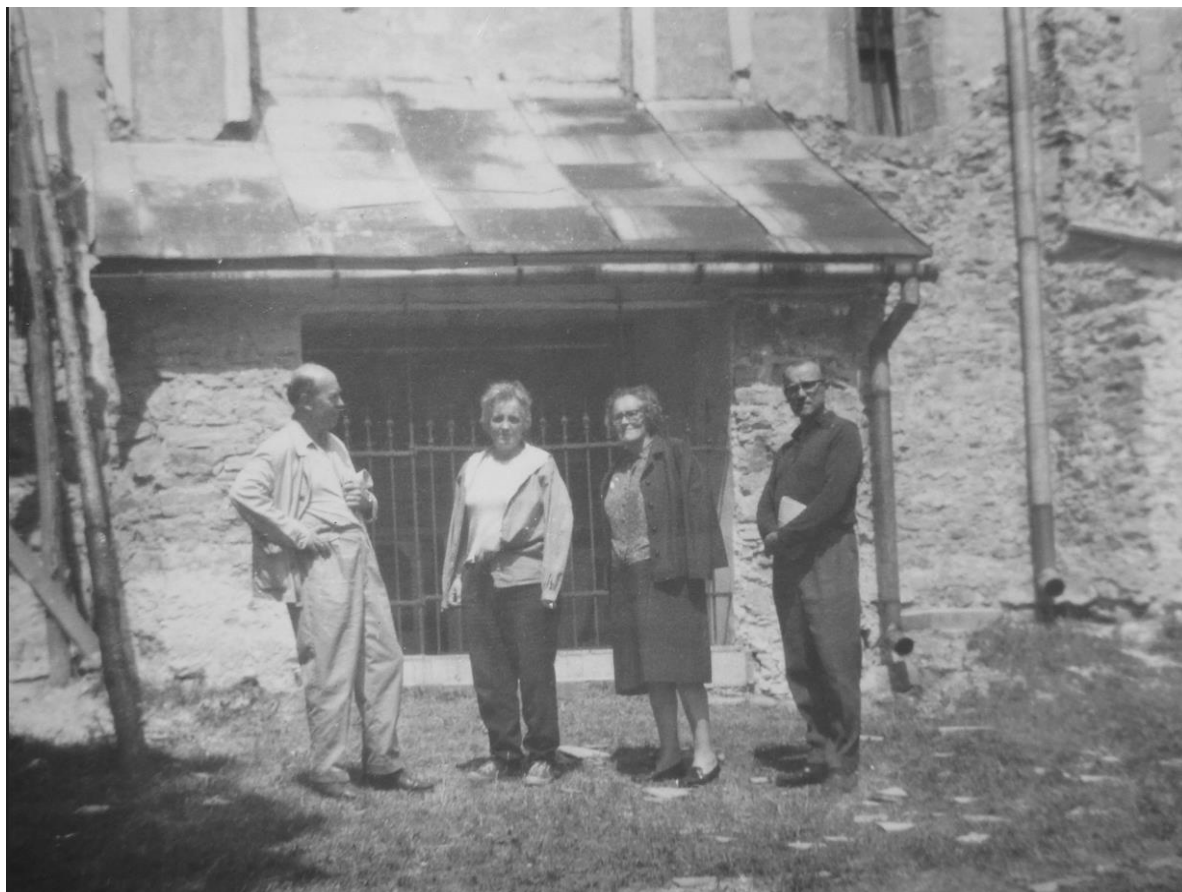
Obr. 8 Kontrolný deň počas rekonštrukčných prác na kostole (Zdroj: AFÚ Gaboltov)
